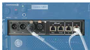
Einbau im Technik-Rack Casino 1.801.
