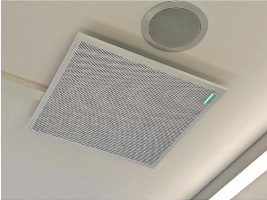
Abb. 09: Deckenmikrofon
