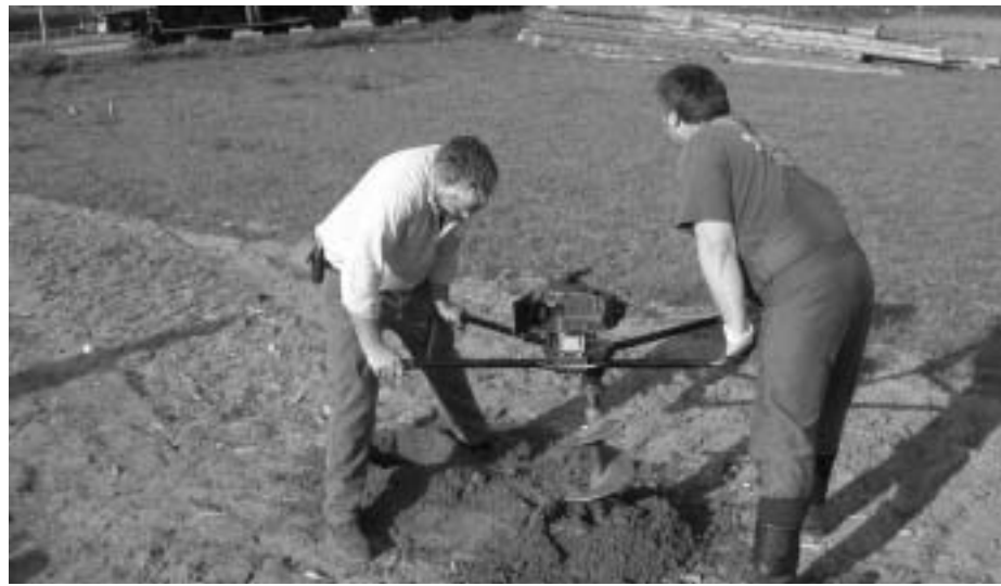
Der Zivilisation sei Dank: In der Steinzeit gab's noch keine motorgetriebenen Bohrer. Gründungsvorbereitungen für den Aufbau des rekonstruierten Langhauses der ersten Hessischen Bauern auf dem diesjährigen Hessentag.
