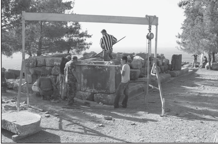
Resim 1: Priene 2007. Mısırlı Tanrılar Kutsal Alanı. Tapınak podyumunun restorasyonu Abb. 1: Priene 2007. Heiligtum der ägyptischen Götter. Restaurierung des Tempelpodiums
