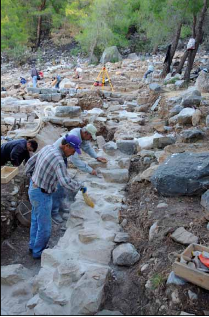
Abb. 15: Nordwestviertel. Sicherung der Mauerkronen (Foto U. Mania)
