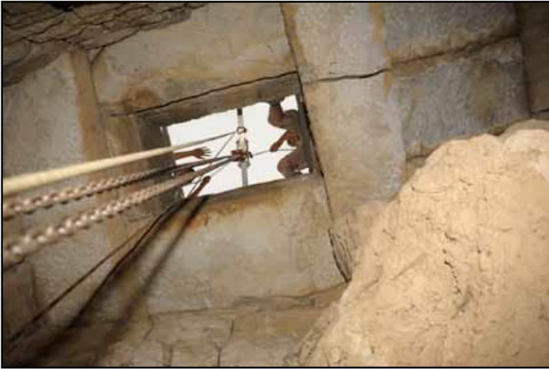
Abb. 14: Wasserschacht. Abdeckung von unten (Foto J. Ulbrich)
