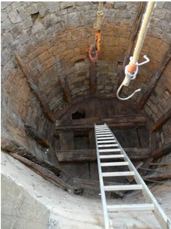
Innenansicht des zylindrischen Baukörpers nach Herausnahme der Verfüllung. Quelle: Hessisches Baumanagement
